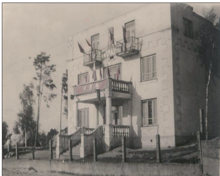
Wynajęty budynek murowany
